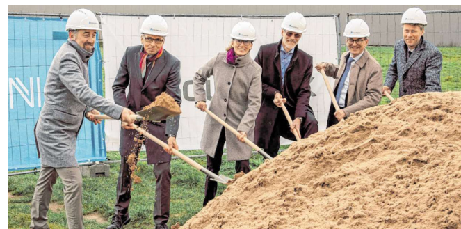
Groß war die Freude bei allen Beteiligten über den ersten offiziellen Spatenstich für das neue Verwaltungs- und Fertigungsgebäude der Firma atg Luther & Maelzer auf dem Wertheimer Reinhardshof.
